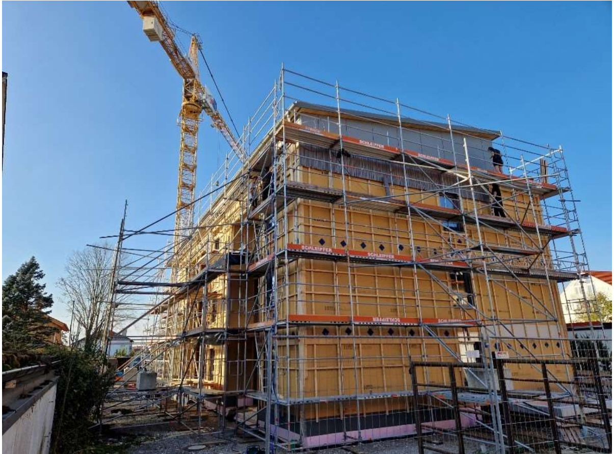
Auf einem Grundstück zwischen Münchener Straße und Bahnhofsgasse entsteht der Neubau (Foto: Stadtbauamt Weilheim)
